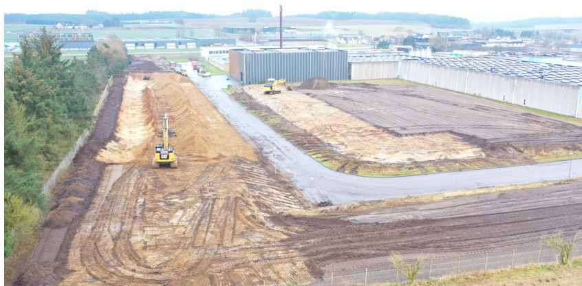
Byggeriet under opførelse Foto: Daugaard Pedersen A/S
