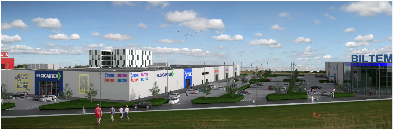
Roskilde Retail Park: Nye varehuse til Jysk og Elgiganten m.fl. Foto: Visualisering udarbejdet for Daugaard Pedersen A/S
